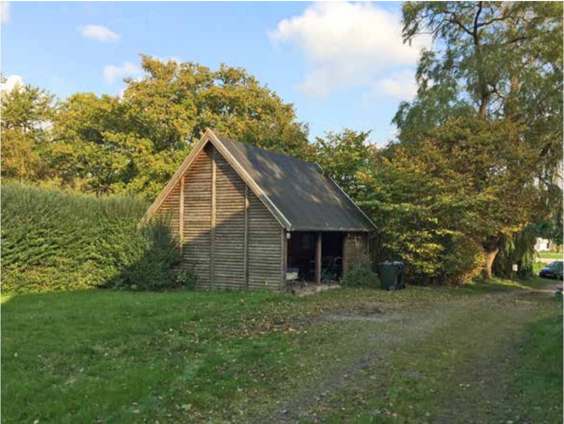
↑ Udhusbygning set fra nord
