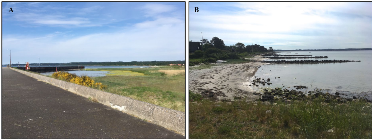
Figur 33 A-B: (A) Vest for NATO-molen er der i dag opstået et mindre marint forland med en lille kystlagune. (B) Øst for molen eroderes kysten og der er etableret høfder, som skal fange sediment for at mindske erosionen af kysten (Miller 2020).
